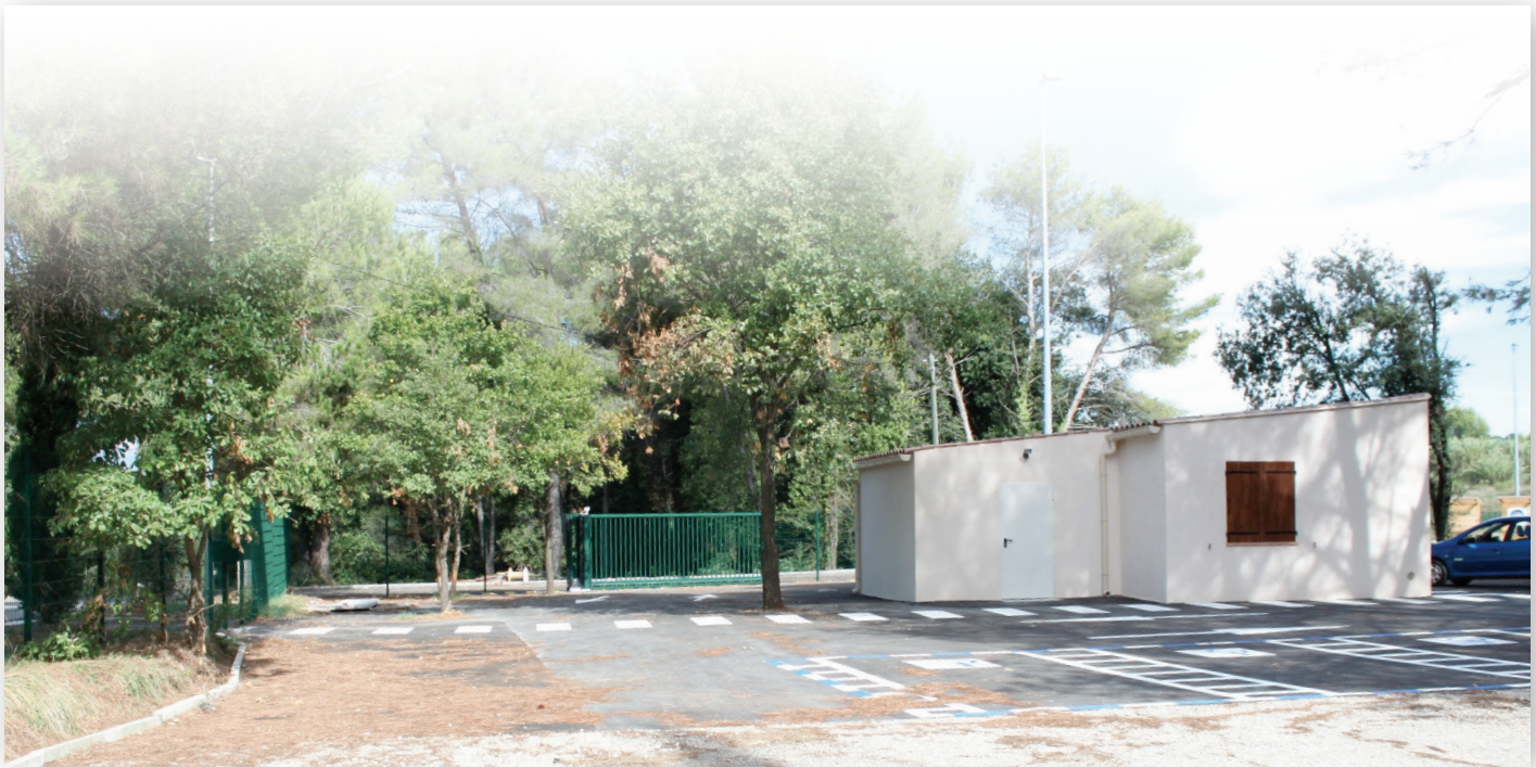
Parking, clôture grillagée et local.
